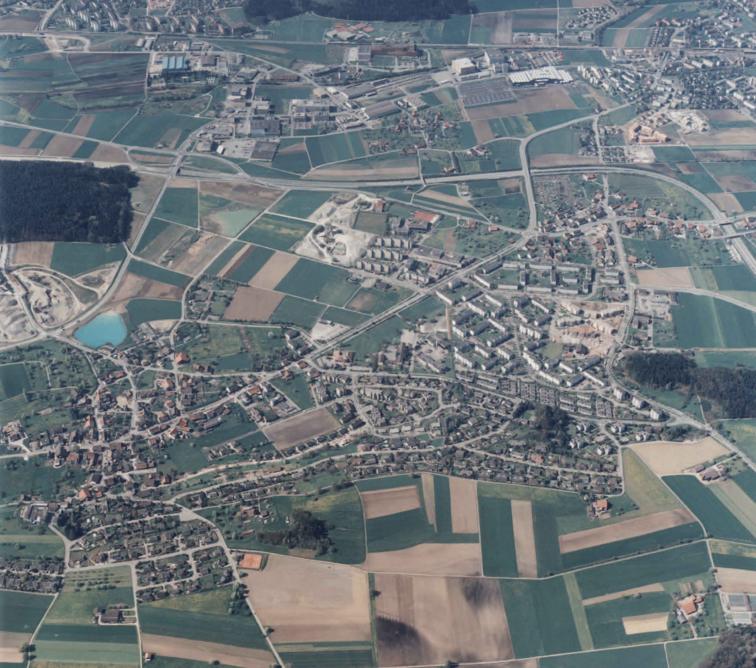
Volketswil und Hegnau 1985 Luftaufnahme
