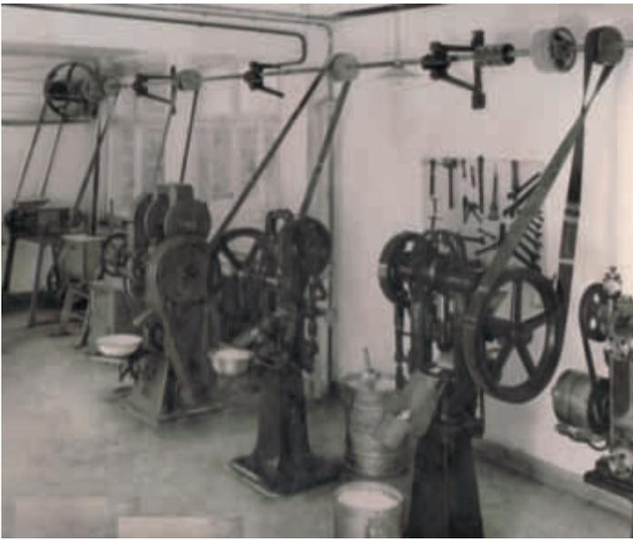
Mit dem Umzug nach Volketswil wird die Produktionskapazität für die Forsanose-Präparate dem rasch steigenden Bedarf angepasst. Die in der ehemaligen Seidenzwirnerie installierte Escher-Wyss-Wasserturbine liefert über eine Riementransmissionsanlage die Energie für die Pillenpressen.
