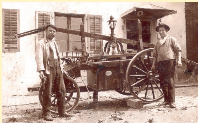
Feuerwehrspritze Hegnau vor dem Feuerwehrlokal im Erdgeschoss vom Chappeli.
