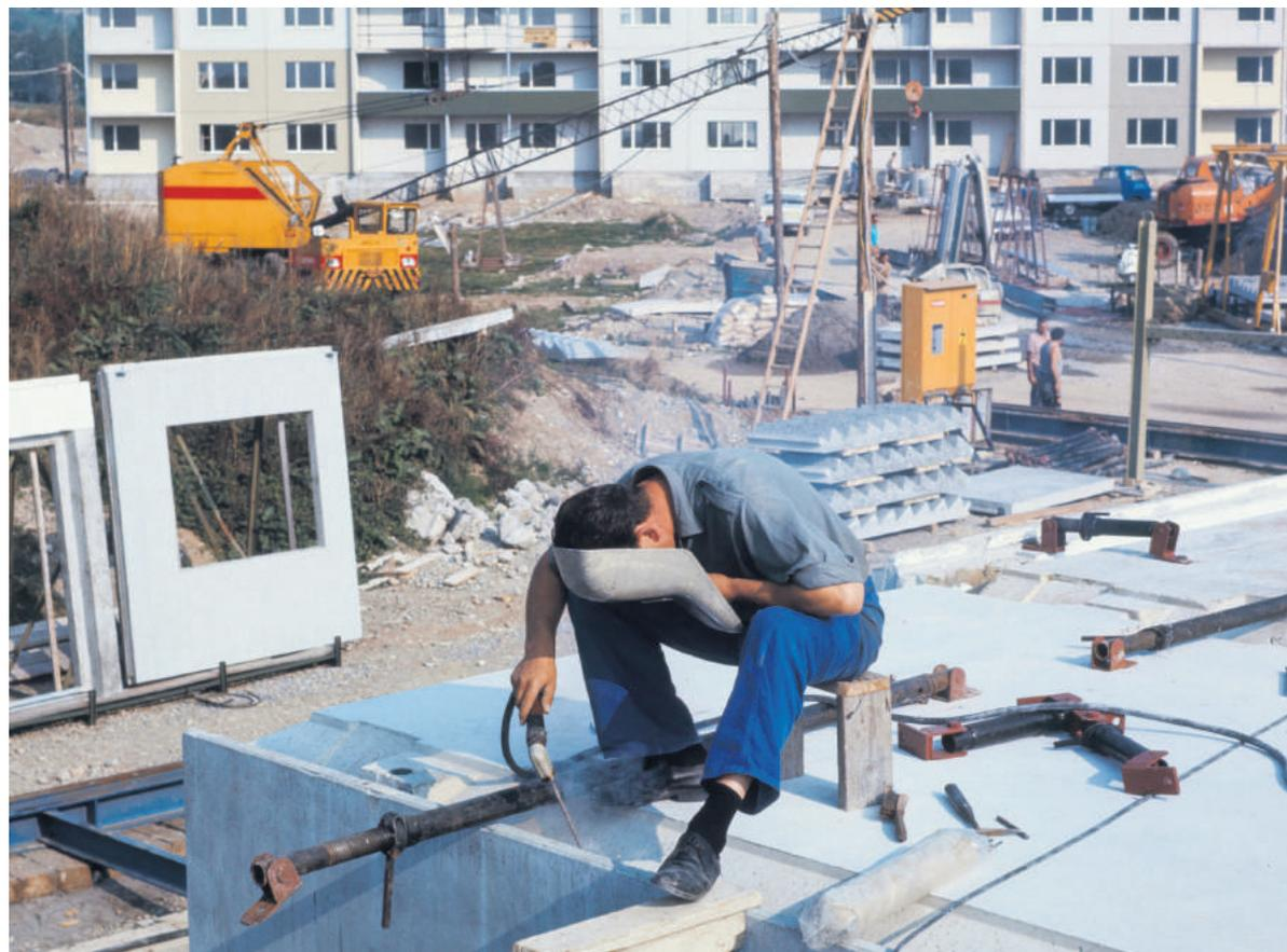
Die in die Betonelemente eingegossenen Stahlstifte werden miteinander verschweisst und verbinden so die ganze Konstruktion. (Comet, ETH Bibliothek)
