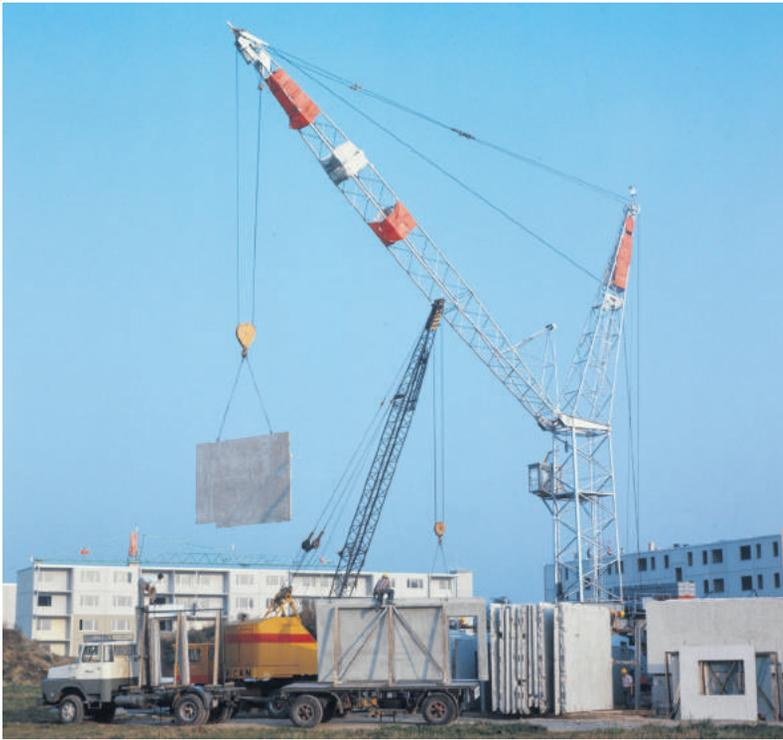
Aus dem grossen Igeco-Vorfertigungswerk im Industriegebiet Volketswil bringen Lastwagen die montagefertigen Betonplatten für Wände und Decken auf die Baustelle im Sunnebüel. (Comet, ETH Bibliothek)
