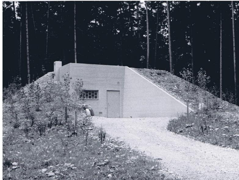
Das neue 500-Kubikmeter-Wasserreservoir im Buchholz auf der Egg versorgt seit 1968 Guteswil mit Wasser, das aus dem Grundwasserpumpwerk Giessen in Volketswil heraufgepumpt wird.
